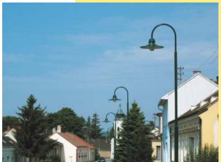
Eibesbrunner Hauptstraße Neue Straßenbeleuchtung
