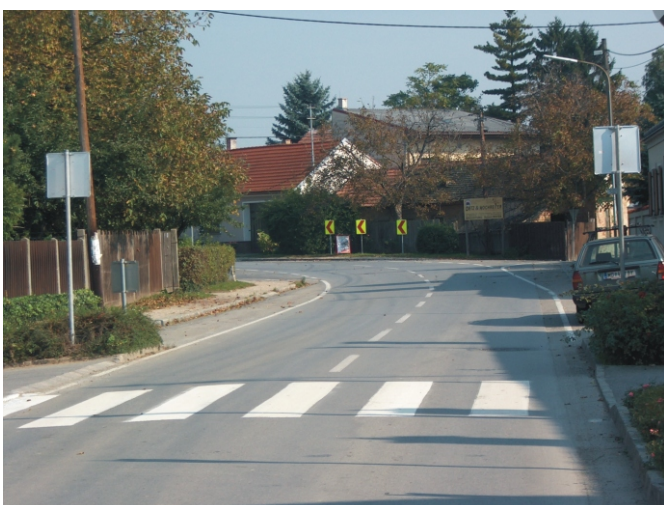
Reflektierende Umrahmungen für Verkehrszeichen "Achtung Schutzweg", Leitlinie und Richtungspfeile Großebersdorf, Münichsthaler Straße
